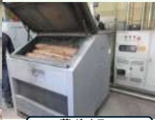
薪ボイラー (蓋を開けた様子)
