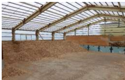
図 3-33 ひだか南森林組合の熱利用向けチップの保管場所（旧プール）
