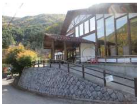
図 3-51 ボイラー導入施設
