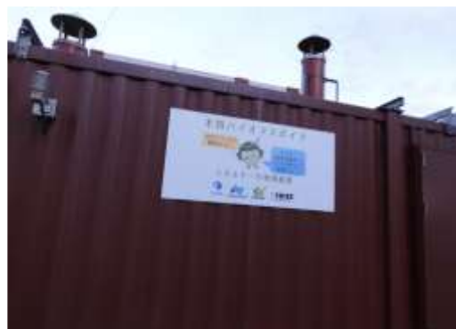
図 3-26 西当別小学校ボイラー建屋
