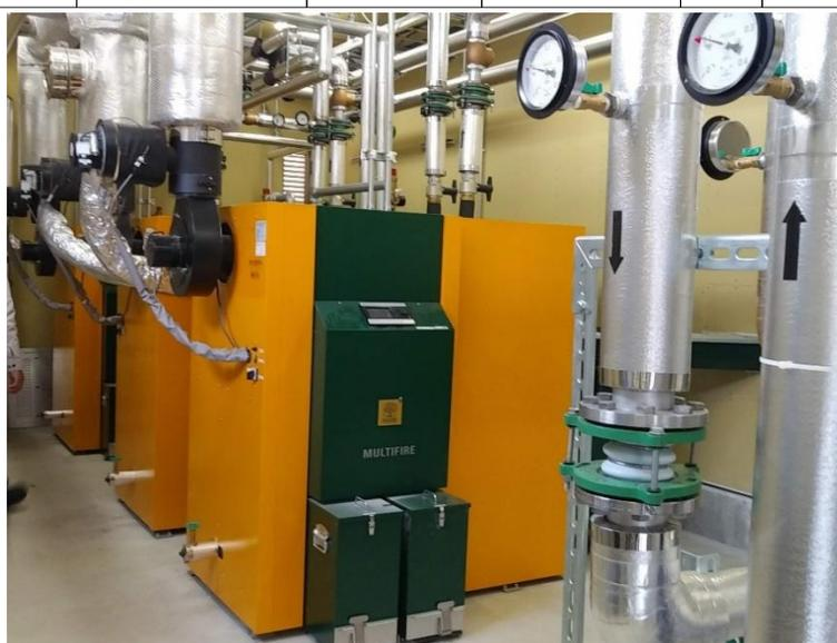
図－23 事例 No.5 白鷹陽光学園のボイラー室内部の様子
