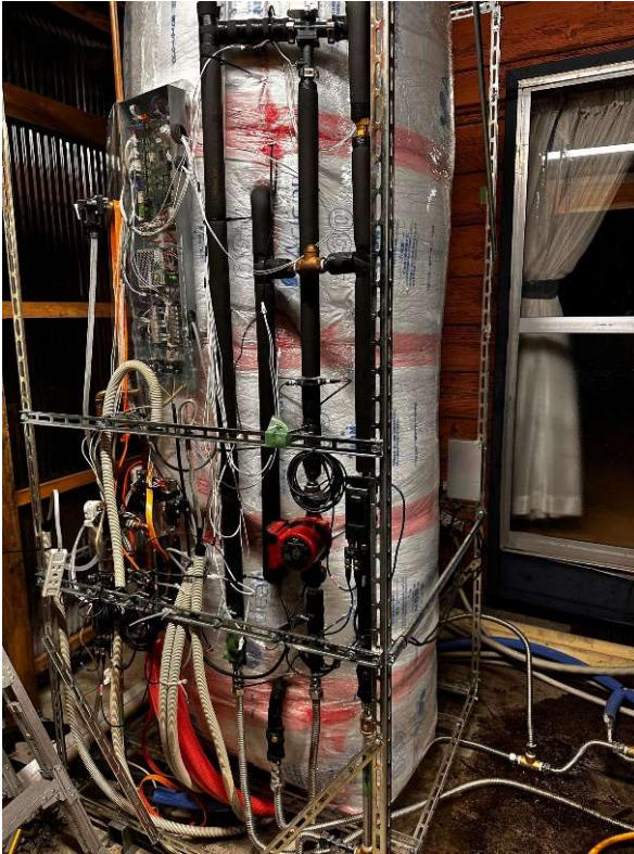
外装内部のタンク断熱 32Kグラスウール100mm保温
