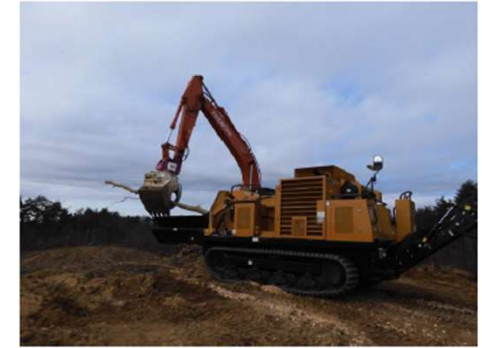
グラップルによるチッパーへの残材投入
