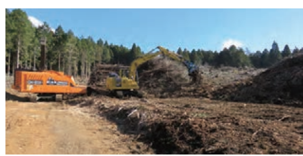
作業効率を上げるため、枝付きの梢端部を可能な限り長いまま方向を揃えて集積します。
