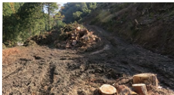
集積された枝条です。チップパーの回送が可能であればここで破碎し、発電所まで直送します。
