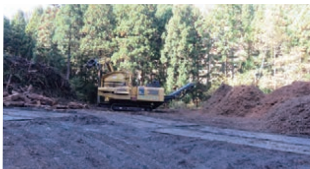
現場にチップパーを回送できない場合は施業地近くにチップング用の土場を設けて破碎します。
