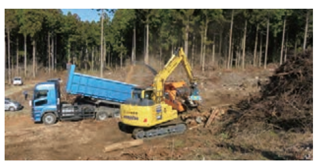
チップ化の際、チップはチップパーから直接トラックの荷台へ吹き込むことで効率化を図っています。少人数で作業ができるよう、グラブオペレーターがチップパーをリモコンで操作します。
