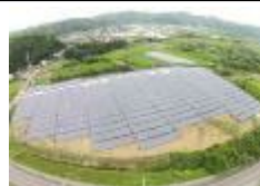
高知第一発電所 （高知市）
