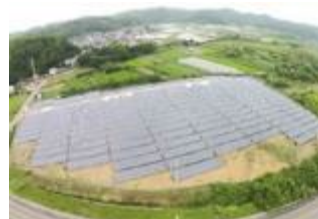
高知第一発電所 (高知市)
