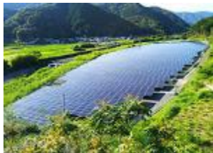
室戸第二発電所 (室戸市)
