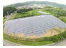
高知第一発電所 (高知市)
