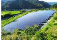
室戸第二発電所 (室戸市)
