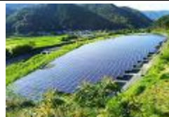
室戸第二発電所 （室戸市）
