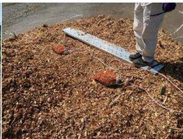
サンプルバック・センサー類の設置
