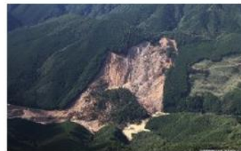
平成29年9月 台風12号による紀伊半島豪雨災害
