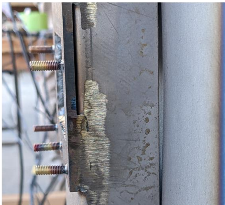
t3.2 0.2MPaでの背面。 変形によりダクトとの間に隙間ができる
