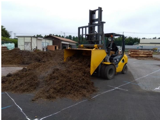
重機による試験区の設置
