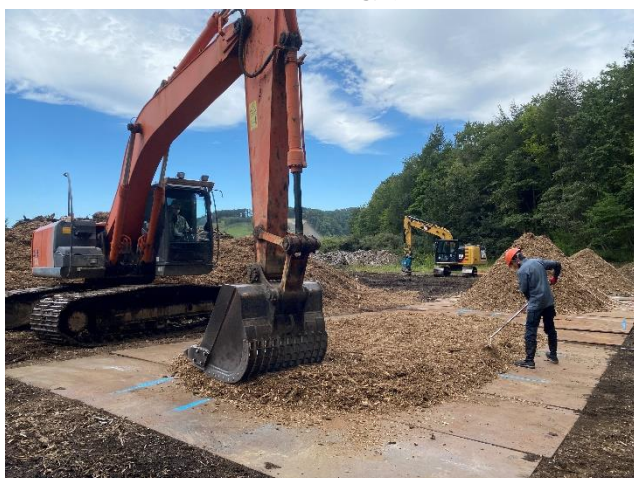
重機による試験区の設置
