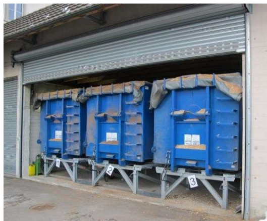
図6.2サイロの代わりに充填されていないモバイル木材チップコンテナ (出典: Holzenergie Schweiz)
