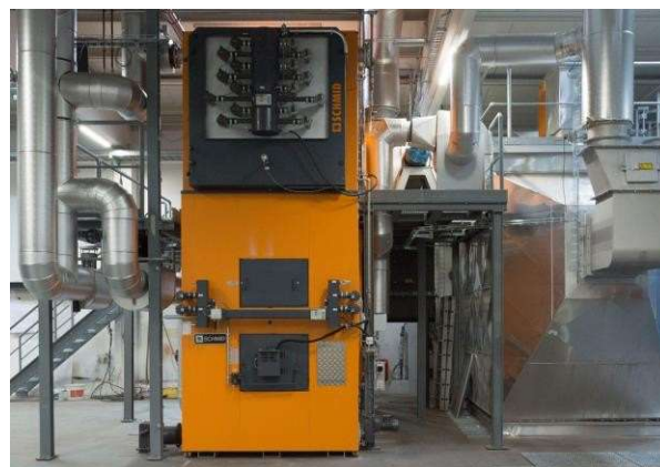
図5.11ボイラーチューブの自動洗浄（出展：Schmid ENERGY Solutions）
