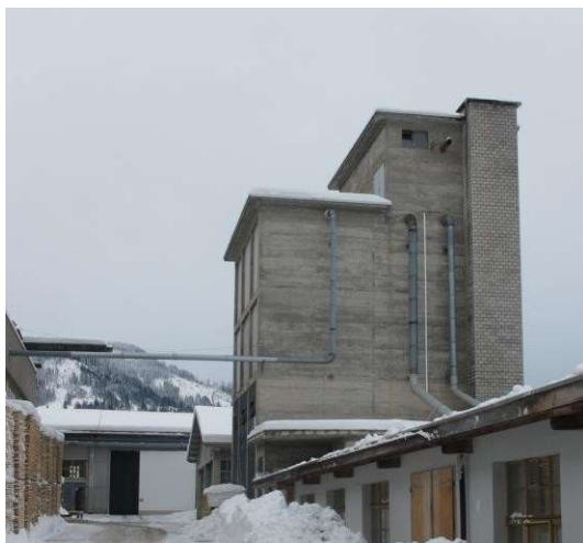
図6.4 のチップサイロ(出展: Wooden Energy Swit- zerland).
