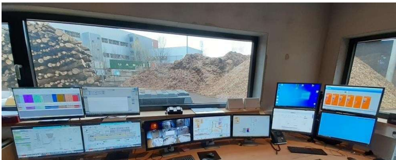
図5.24 バイオマスCHPプラントの制御室（出典：AEE INTEC）。
