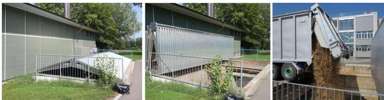
図6.10アクセスできない折りたたみ式の蓋(左が閉じていて、中央が開いていて、右がいっぱいです)(出典: Patrik Küttel)
