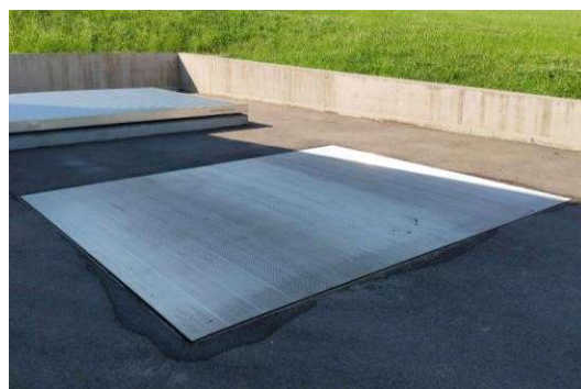
図6.9サイロの蓋は背景ではアクセスできず、前景ではアクセスできません。両方とも閉じた状態(出典: Schmid ENERGY Solutions)
