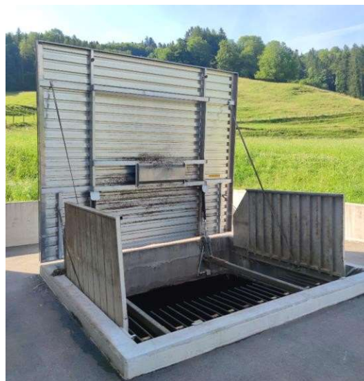
図6.8サイロの蓋が開いているときにアクセスできません(出典: Schmid ENERGY Solutions)
