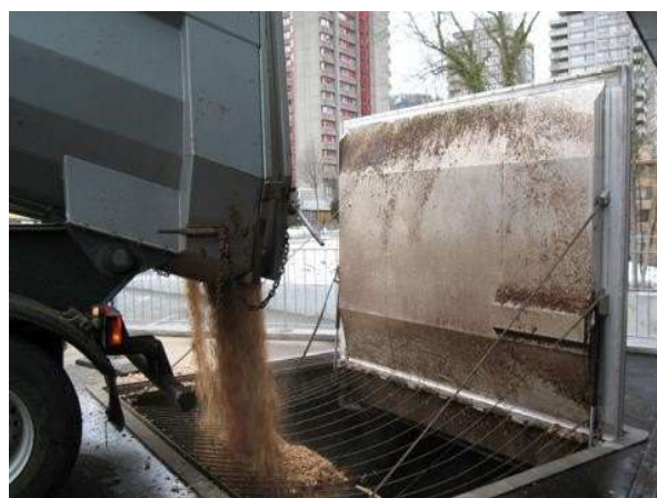
図14.1 地下サイロへの供給(出典: Holzen-ergie Schweiz)
