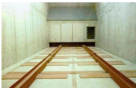
図6.21：プッシュフロアによるサイロ排出（出展：Schmid ENERGY Solutions）
