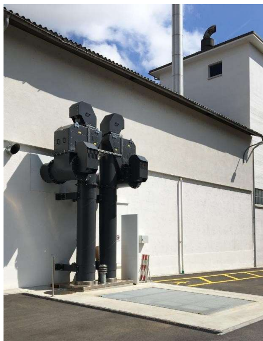
図6.13垂直スクリュウコンベアシステム (出展: Schmid ENERGY Solutions)
