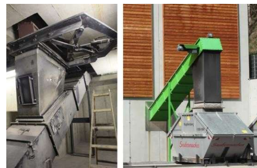
図6.41: 機械式灰除去コンベア: スクレーパチェーンコンベアを使用しています(出典: AEE INTEC)。
