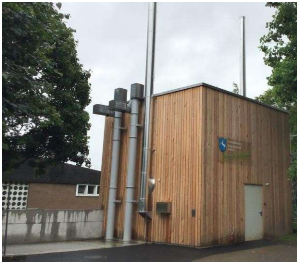
図13.32 統合または追加の燃料貯蔵タンクを備えたプレハブとしてのセントラルヒーティングプラント（供給元：Holzenergie Schweiz）
