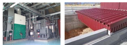
地下式 -チップサイロ- -チップボイラー- 出典:林野庁「木質バイオマス熱利用・熱電供給事例集」
