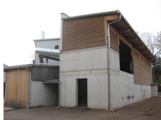
既存地域熱供給へのCHP (180kW)の追加導入
