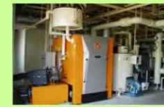
木質バイオマスボイラー
