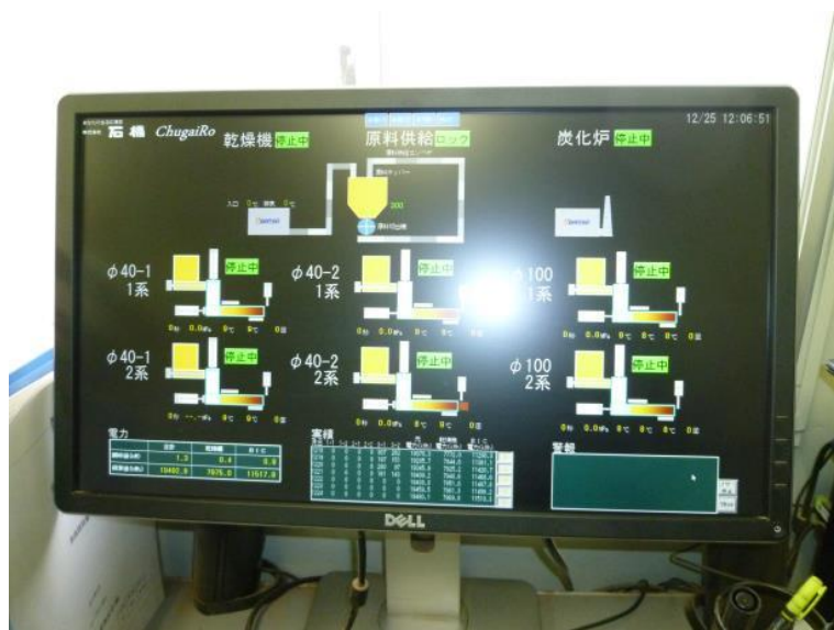
管理モニター(工場内)
