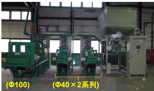
ユニット3系列設置時の外観 (株)石橋・切目資源工場
