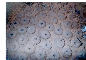
熱交換器(内部)
