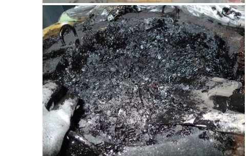
一次冷却器下部(試験後)
