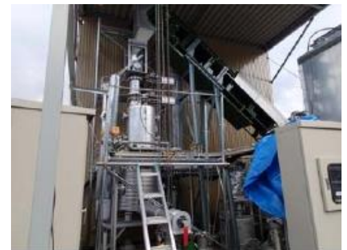
ガス化炉全景
