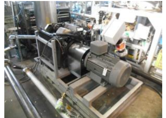
本システムで採用した エンジン発電機
