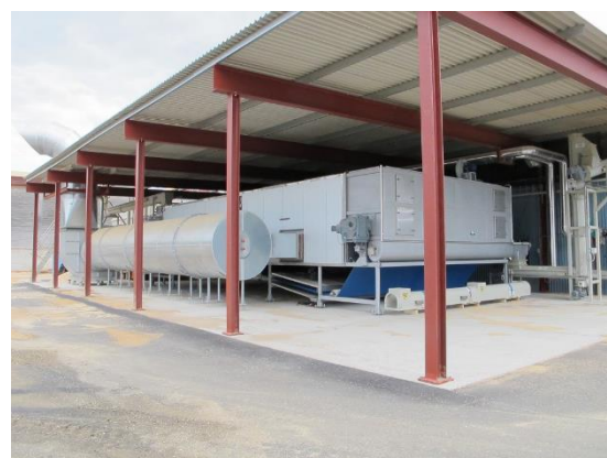
図表 4-26 ペレット工場に導入された ベルト式乾燥機（スウェーデン）
