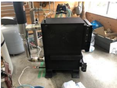
試験設備の写真
