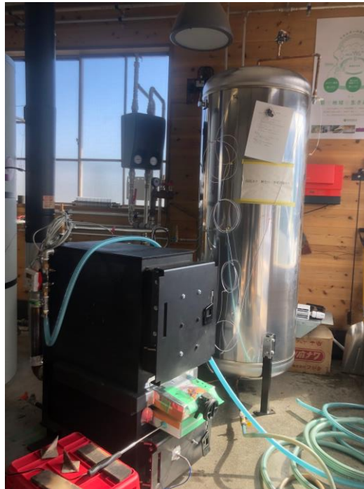
試験設備の写真
