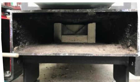
二次燃焼室内 三角平板設置状況
